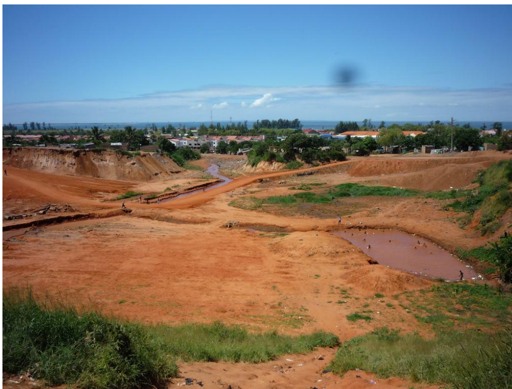
Figura 3-57: Bacia de retenção inacabada a Norte de Sommerschild (na Av. Julius Nyerere)
