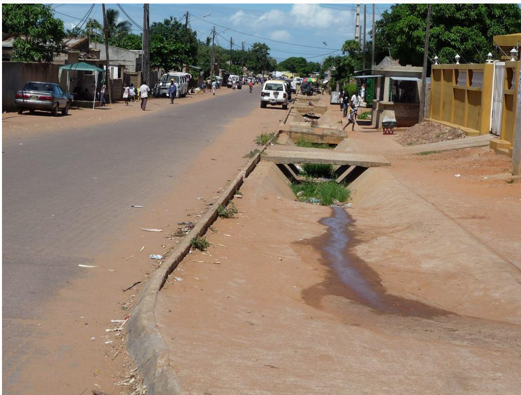
Figura 3-54: Canal secundário no Bairro Sommerschield / Polana Caniço A (próximo a bacia de retenção)
