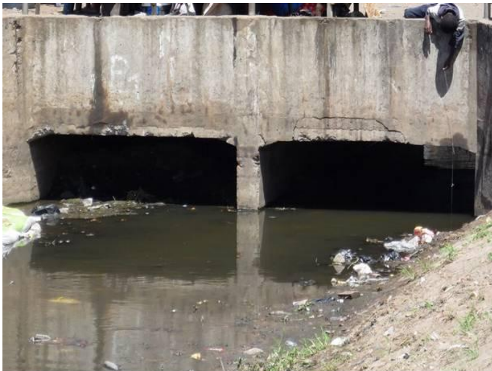
Figura 3-33: Canaleta no canal de águas pluviais ao longo da Av. Acordos de Lusaka no Bairro Maxaquene A
