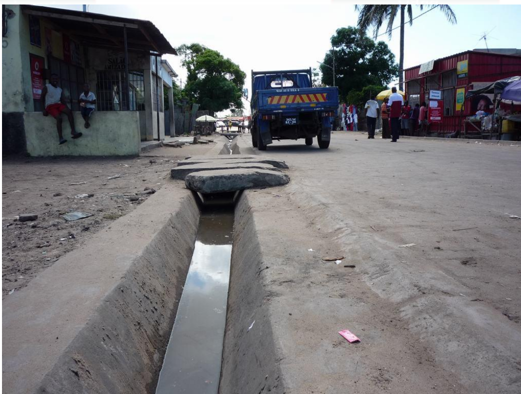
Figura 3-48: Canal secundário no Bairro Mafalala. Bloqueado por baixo das lajes de betão que foram colocadas sobre o canal para passagem pedonal
