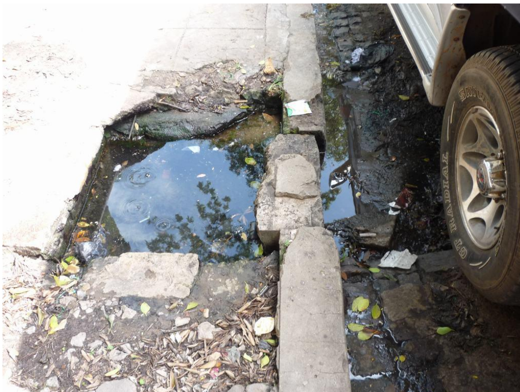
Figura 3-45: Entrada de águas pluviais na cidade de cimento de Maputo: bloqueada, água não entra no sistema de esgotos
