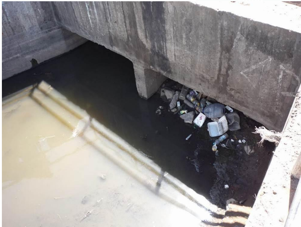
Figura 3-34: Vista de trás da mesma canaleta
